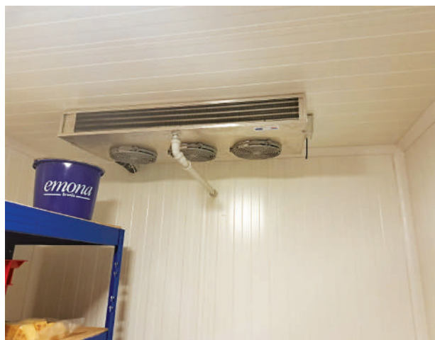
Slika 2. Uređaj za brzo (forsirano) hlađenje u preradi mlijeka
