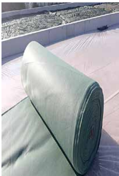
Slika 2. Pokrivanje silosa s Flortex 500 preko folije sa smanjenom propusnošću za kisik
