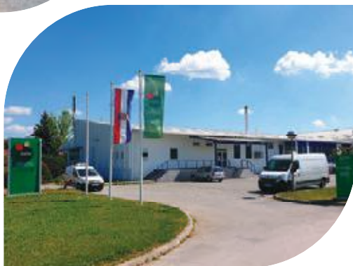
Zgrada Laboratorija, 2022. godina
